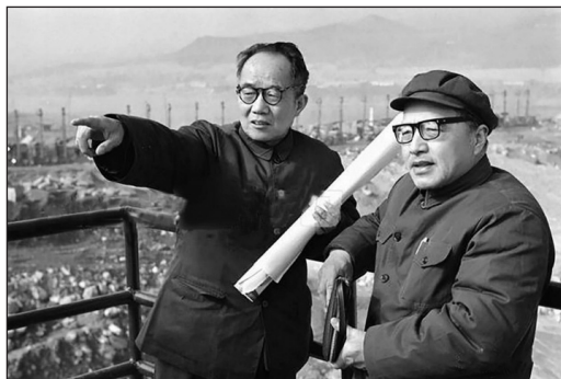
从丹江口水利枢纽工程转战葛洲坝水利枢纽工程的两位曹总，左为设计总工程师曹乐安，右为施工总工程师曹宏勋。原载1982年2月23日《人民日报》
